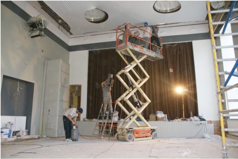
Tsooru rahvamaja saali pinglae paigaldamine foto: KALLE NURK
