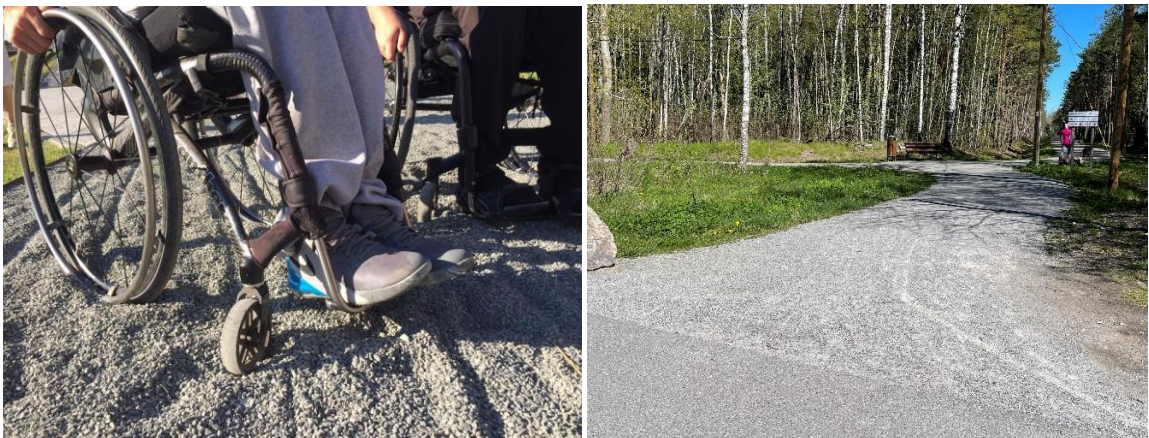
Tihendamata peenkillustik ei võimalda ratastooliga liikumist, Rakvere Laululava kõnniteed. Näide – Õismäe raba terviseraja tihendatud killustiksõelmega kõnnitee on väga hästi läbitav ratastega abivahendite.
